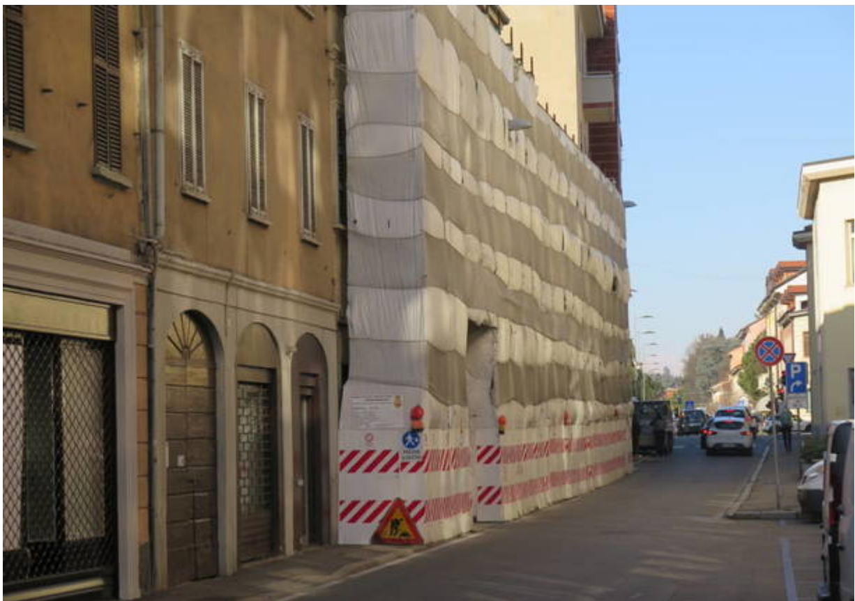
via Mazzini nuovo ingresso: sarà eliminata la lanterna semaforica verso via Roma
