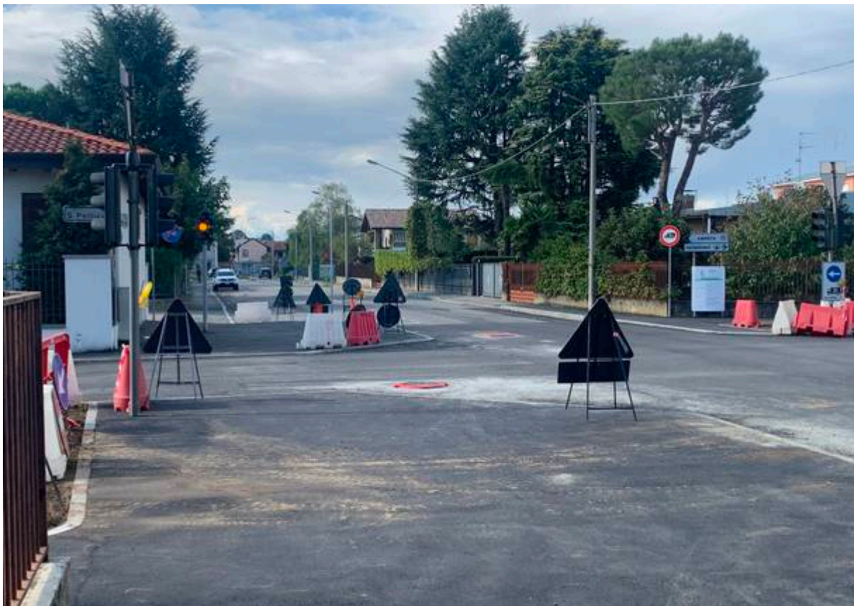
Il cantiere all'incrocio tra via Giovanni XXIII – al centro della foto – e via Silvio Pellico
