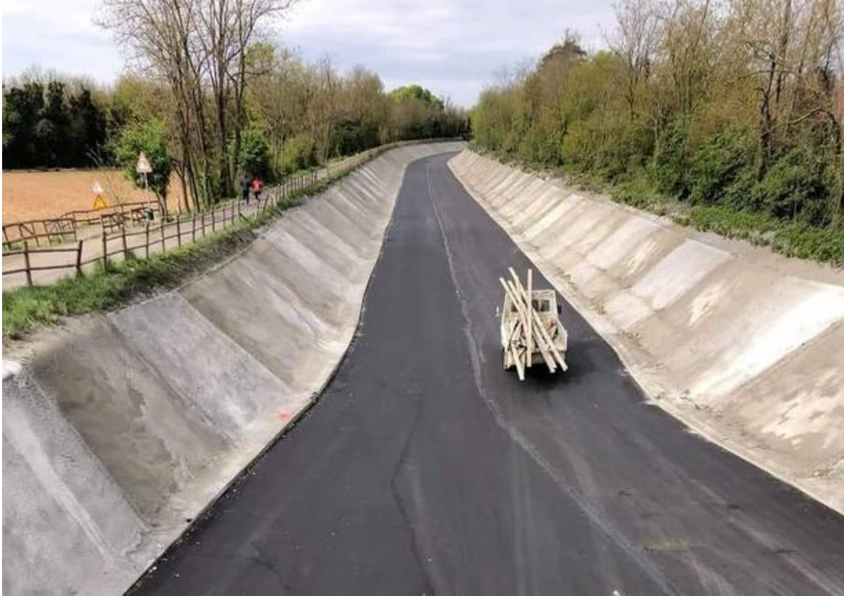
Il cantiere di ripristino del fondo del canale Villoresi
